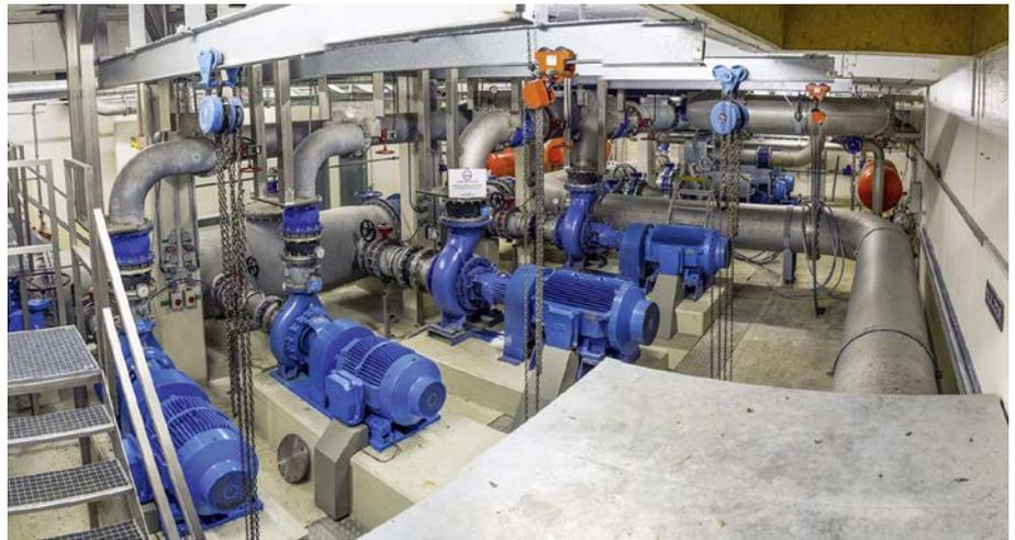
Sept pompes (quatre EPFL et trois UNIL) extraient l'eau du lac à environ un kilomètre du rivage et 69 mètres de profondeur. F. Ducrest © UNIL
