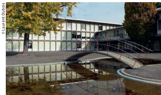
Groupe scolaire du Belvédère (1953-1956)
