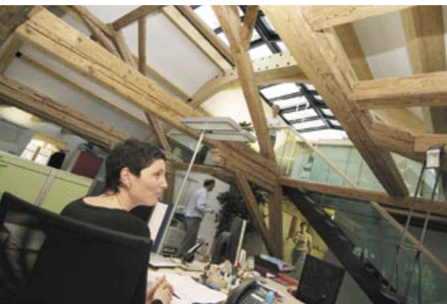
Bureau dans les combles du château de Dorigny: l'ancienne poutraison se marie avec le bois de la nouvelle structure.
