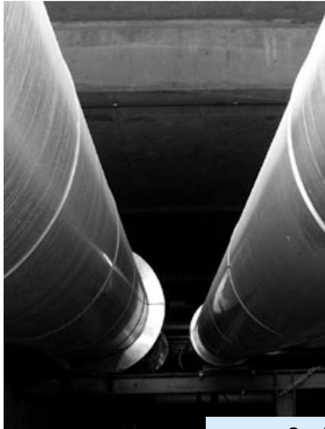
Deux impressionnantes conduites drainent sans relâche les eaux du lac à travers le campus. L'installation commune entre l'UNIL et l'EPFL, dévolue en partie au chauffage, en partie à la climatisation, ne répond plus aux besoins actuels et à venir. Une nouvelle conduite de 450 mètres de long est en cours de travaux.
